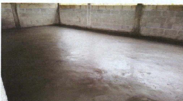
Foto 4: Mejoramiento de puertas, pisos y ventanas de aula de tercero primaria
