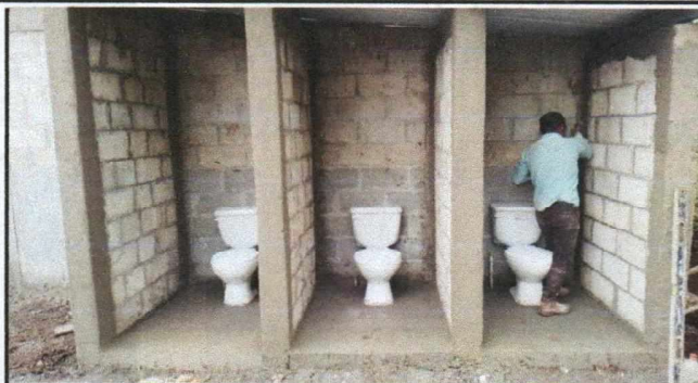
Foto1: Mejoramiento de servicios sanitarios
