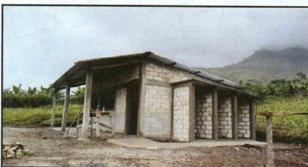
Foto 6: Estructura de techo y cubierta de lámina
