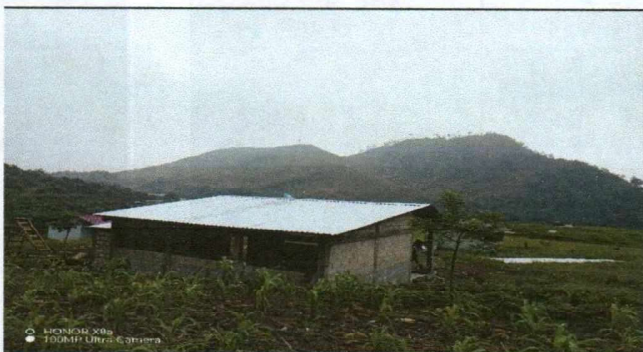
Foto 3: Mejoramiento de puertas, pisos y ventanas de aula de tercero primaria
